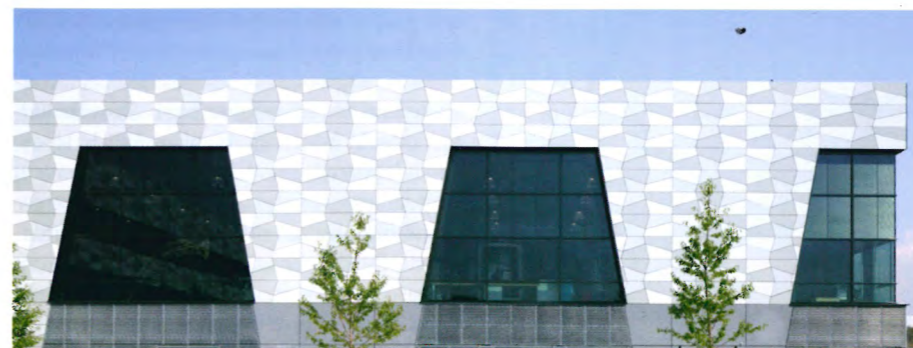
Im Scheibenzwischenraum sind feststehende Lamellen integriert, die einen Großteil der solaren Strahlung nach außen reflektieren und dadurch den Innenraum vor direkter Sonneneinstrahlung schützen.
