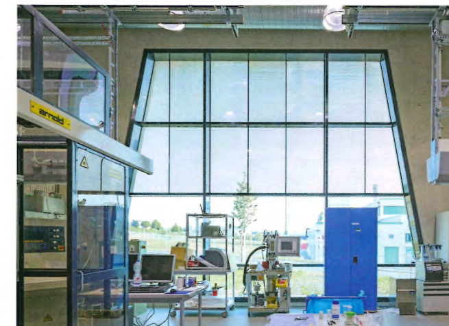
Isolierglas mit optisch geregeltem Sonnenschutz: Innen kann bei Tageslicht ohne Blendung gearbeitet werden. Bild: Yohan Zerdoun | Okalux
